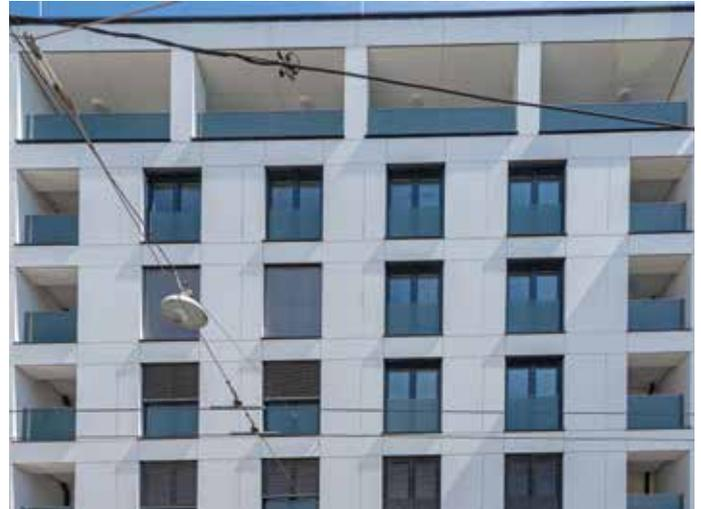
*Anders als bei Wärmedämmverbundsystemen, so genannten Putzfassaden, gibt es bei der vorgehängten hinterlüfteten Fassade eine konstruktive Trennung der Funktionen Wärmeschutz und Witterungsschutz.*
