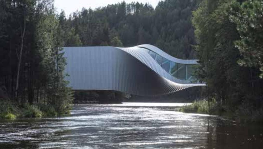
*Die Gebäudehülle aus weißem, eloxiertem Aluminium verformt sich zu doppelt gekrümmten Flächen. Dabei fächern die Profile sich auf und folgen so der Biegung des Volumens. Die thermische Hülle und das Tragwerk selbst setzen sich aus ebenen Teilflächen zusammen.*
