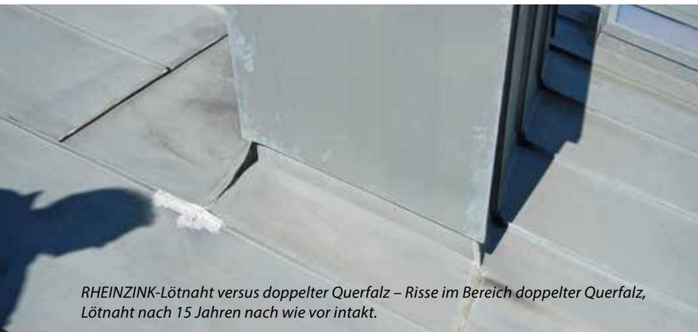
RHEINZINK-Lötnaht versus doppelter Querfalz – Risse im Bereich doppelter Querfalz, Lötnaht nach 15 Jahren nach wie vor intakt.
