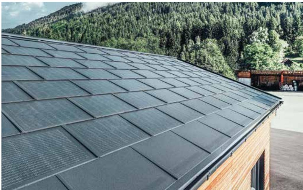
Beim PREFA Solardach handelt es sich um eine 2-in-1-Lösung, also ein vollständiges Dach mit integrierten PV-Modulen. Die Kosten liegen bei ca. 3.000 Euro pro Kilowatt-Peak und inkludieren das Material sowie auch die Montage. | Fotos: © Prefa / Croce & Wir (3)
