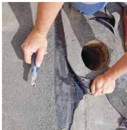
Witterungseinflüsse und UV-Strahlung lassen Bitumenbahnen altern und spröde werden. Die Folge sind Brüche oder gar Löcher, insbesondere an den Schweißnähten.
