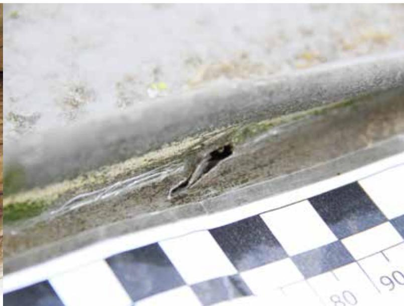
Bild 1: Deutliche Verfärbung von zumindest 2 Sparrenköpfen mit beginnender Moosablagerung und beginnender Vermorschung am Stirnholz des rechten Sparrens. | Bild 2: Das Scheuerloch des Haftfußes, welches den Falzhochzug von der Seite her durchdringt (ca. 15 bis 20 mm Länge).
