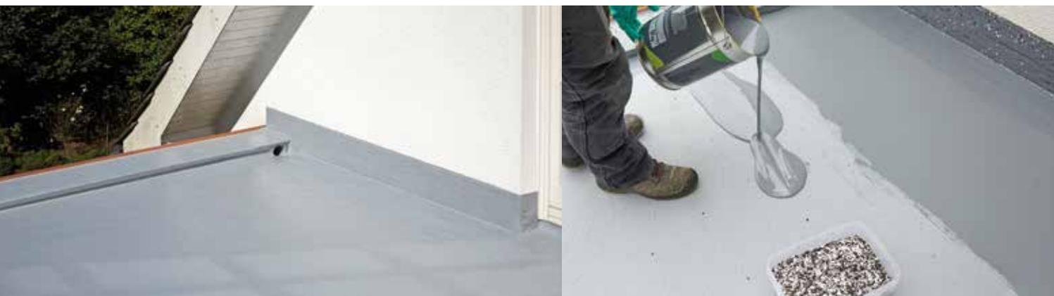
*Mit Vernetzungsbeschleuniger härtet die Abdichtung innerhalb von 3-4 Stunden aus. Chips dienen der Rutschfestigkeit und sind zur optischen Gestaltung in 34 Farben erhältlich.*
