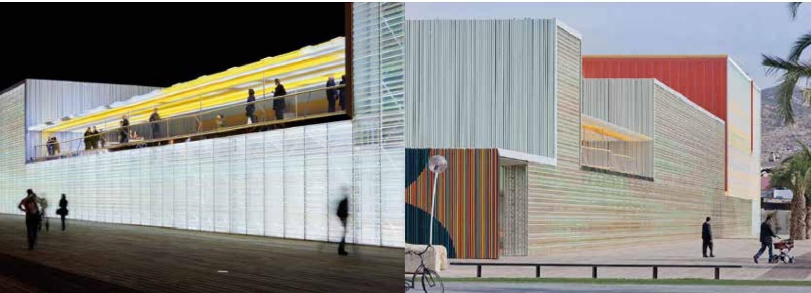
Im Gegensatz zu den Kurzseiten des Gebäudes sind die Längsseiten transluzent. Hier wurden dreifach geknickte Methacrylatprofile verwendet, die im Schnitt einem V mit abgewinkelten Enden ähneln. | Fotos: © Iwan Baan (5)
