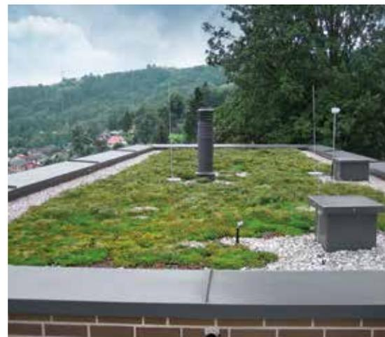
Die Abdichtungen von Triflex sind wurzel- und rhizomfest, sodass bei einer anschließenden Dachbegrünung keine zusätzliche Wurzelschutzbahn aufgebracht werden muss.
