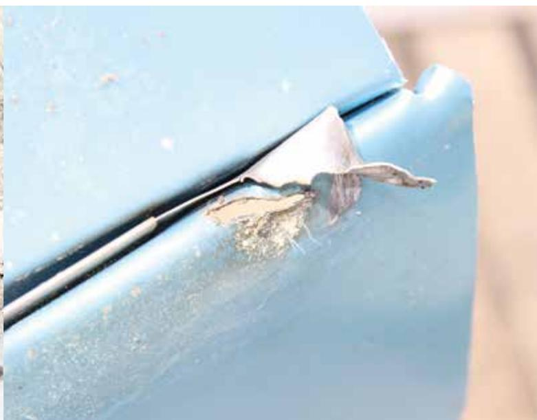
Bild 3: Öffnung des Blechdaches mit der erheblichen Holzvermorschung darunter. Eindeutig sichtbar: Der völlig zerstörte Haftfuß.
