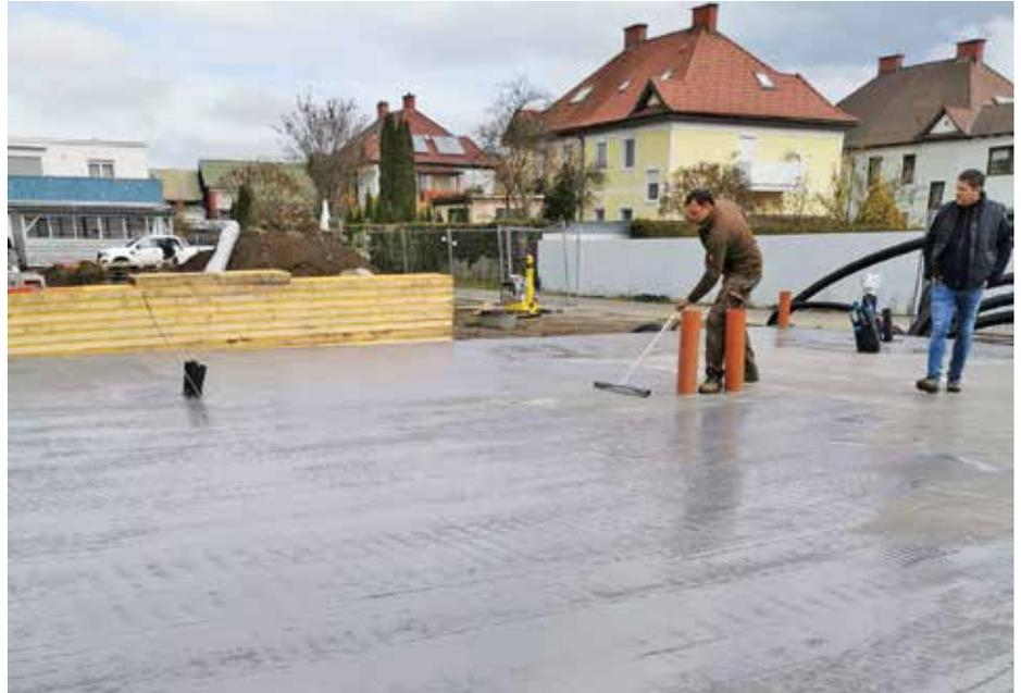
*Aufbringen der Kratzspachtelung, um bei mineralischen Baustoffen die Luftporen in der Oberfläche zu verschließen.*
