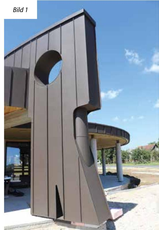
Zahlreiche Spenglerbetriebe ziehen mittlerweile händische Winkel – also Doppelfalzschließer mit Kunststoffauflage – dem Falzautomaten vor. Denn der händische Schließvorgang kann die Fehlerquelle zwischen Falzmaschine und Rollensätzen vermeiden, zudem wird ein optisch besseres Erscheinungsbild erreicht.“
