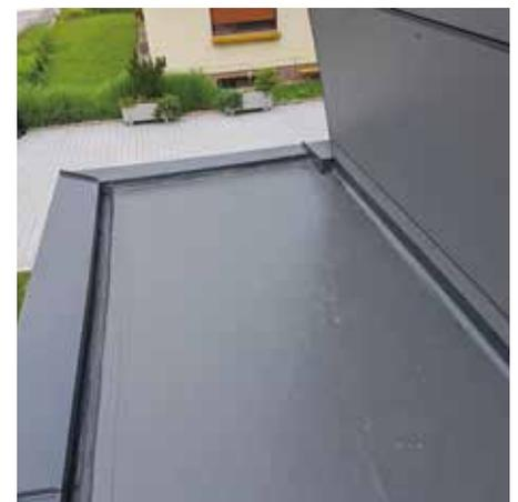
Auch der Anschluss an Attiken kann mit Triflex Flüssigkunststoff sauber ausgeführt werden. Die Kombination aus PMMA und Spezialvlies bildet eine wirksame und langlebige Barriere gegen Feuchteintrag.
