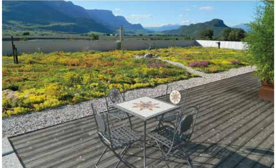
*Gründächer entlasten die Entwässerungssysteme, heizen sich auch bei extremen Temperaturen kaum auf, binden Staub sowie Kohlenstoffdioxid und sorgen für bessere Luftqualität.*
