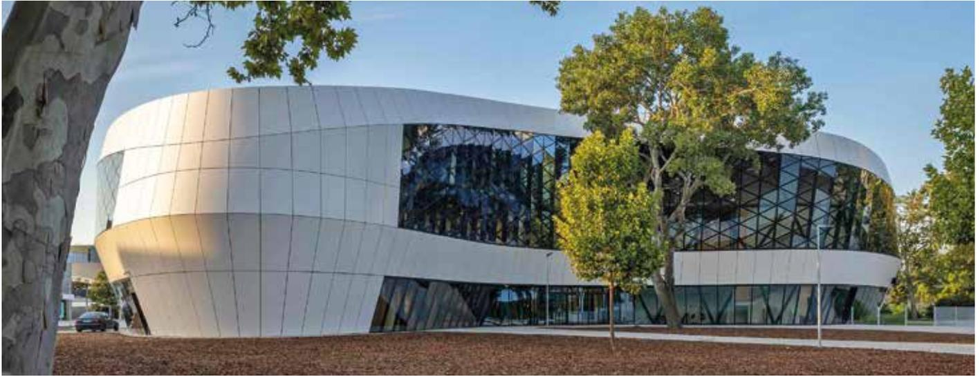
*Die Grundstruktur des Neubaus besteht aus einem Betonkern mit Stahlskelettrahmen. Zusammen tragen sie die gesamte Fassade und das Dach.*
