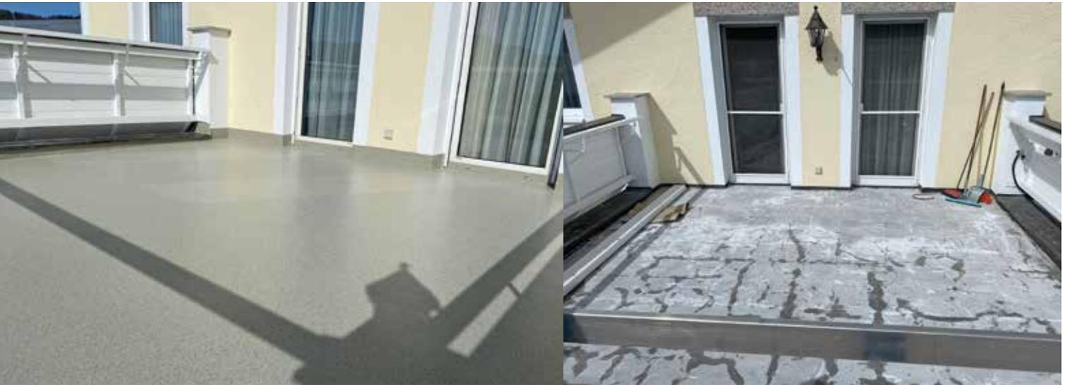
Mit dem Balkon Entkopplungssystem Triflex ProDrain, in Verbindung mit dem Balkon Abdichtungssystem Triflex BTS-P auf Basis von Polymethylmethacrylatharz (PMMA), haben die Verarbeiter der Linzer Santech Bautechnik GmbH einen durchfeuchteten Balkon in Mondsee mit einer neuen Abdichtung und Oberflächengestaltung versehen. | Fotos: © Triflex (4)
