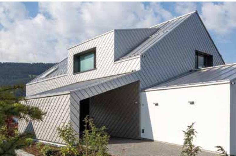
*Komplettsystem aus HFX Edelstahl, Stehfalzdach, Schindelfassade und Dachentwässerung.*
