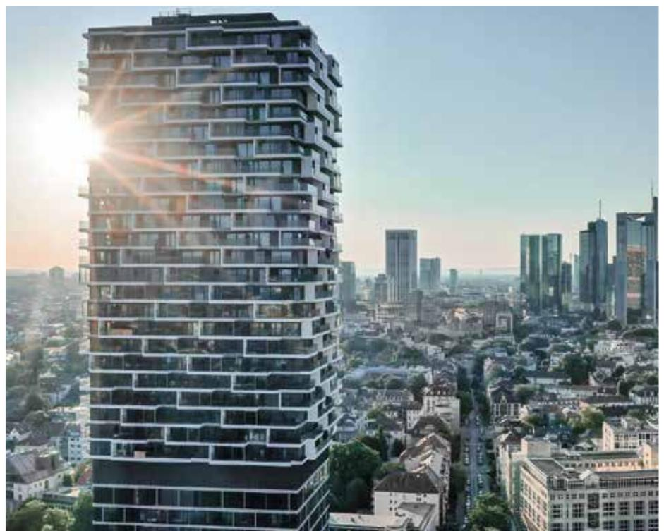
die versetzt zueinander angeordnet sind, sodass sie sich spiralförmig zu einem knapp drei Kilometer langen, aufsteigenden Band um den Turm zusammenfügen, dessen Erscheinungsbild sie im oberen Turmbereich prägen.
