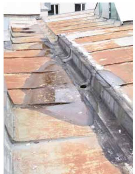
An dieser Stelle ist daher aus technischer Sicht anzumerken, dass diese Art der Instandhaltung (von Wartung kann hier in keinster Weise die Rede sein) völlig fehl am Platz ist und letztlich auch untauglich ist, um die Dichtstellung der Bedachung im üblichen Ausmaß gewährleisten zu können.
