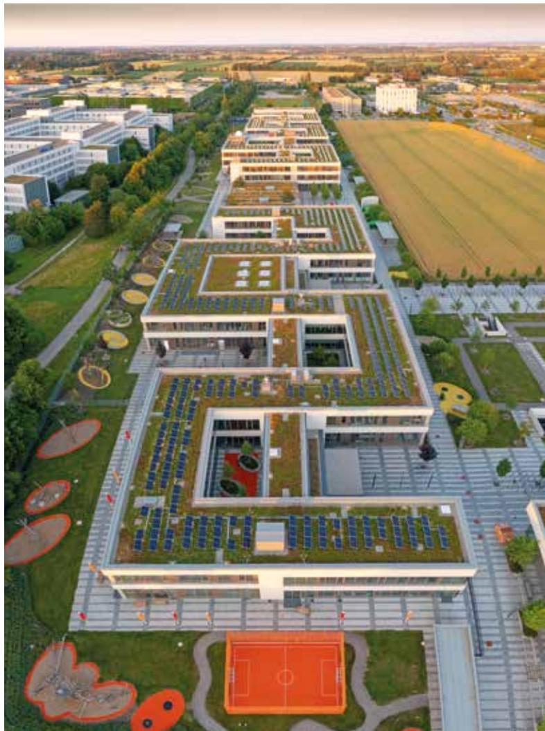
*Mit einer Solaranlage auf Gründächern lässt sich die Photovoltaikleistung im Vergleich zu einem Generator auf einem unbegrünten Dach um bis zu acht Prozent steigern.*
