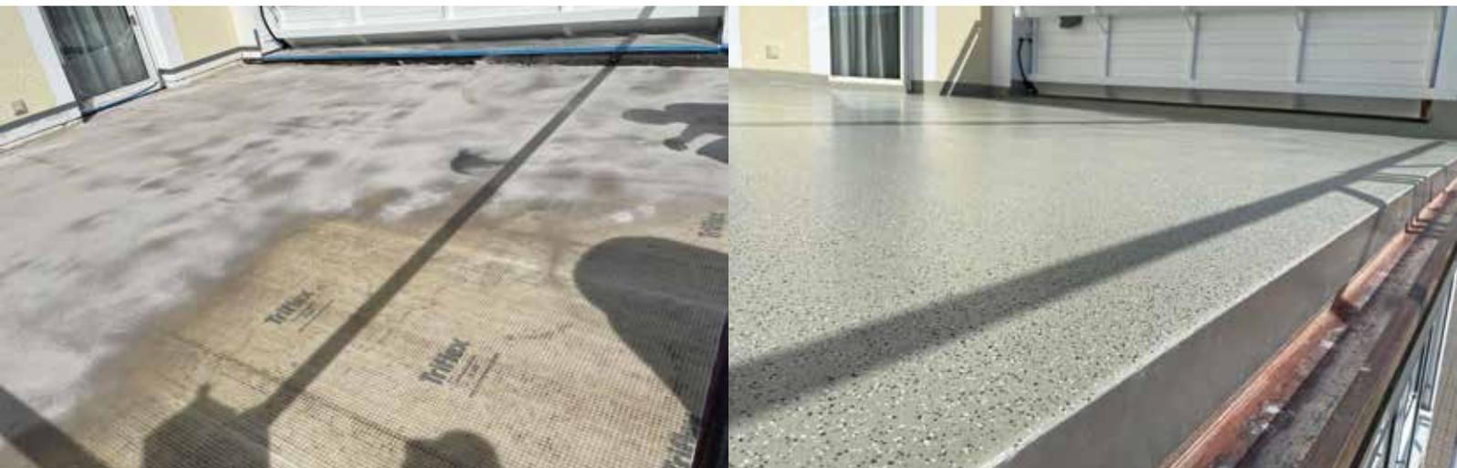
Auf die verklebte Entkopplungsbahn brachten die Verarbeiter Triflex PoxR 100 auf und nahmen eine Abstreuung der Fläche mit Quarzsand in der Körnung 0,2 bis 0,6 Millimeter vor. Anschließend standen das Einkleben des Traufblechs und das Ausspachteln der Hochzüge im Fokus.
