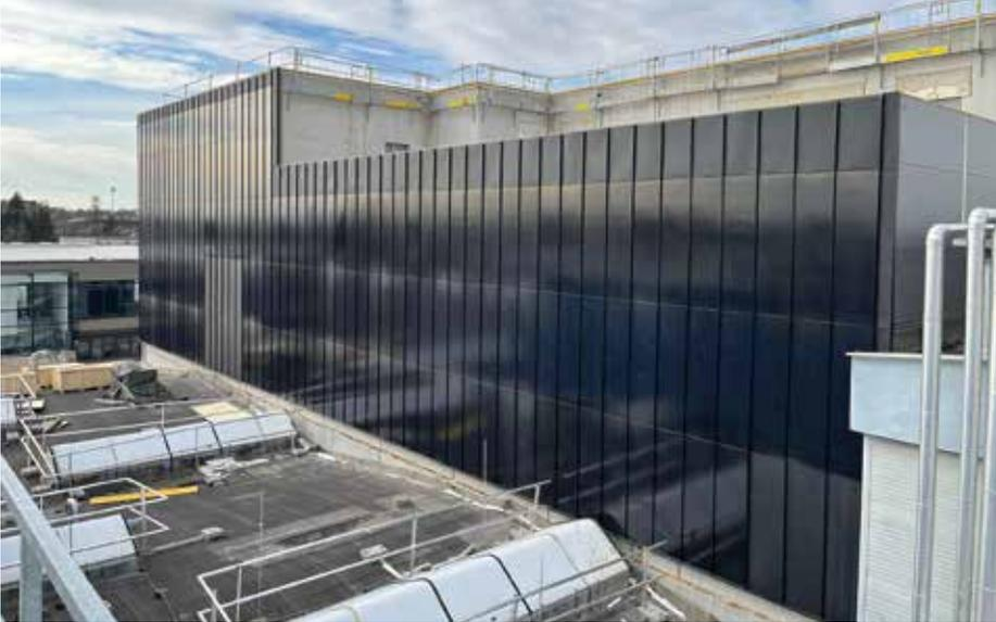
In Zusammenarbeit mit einem Spengler aus Oberösterreich wurde die Fassade mit einer Leistung von 30,96 kWp umgesetzt.
