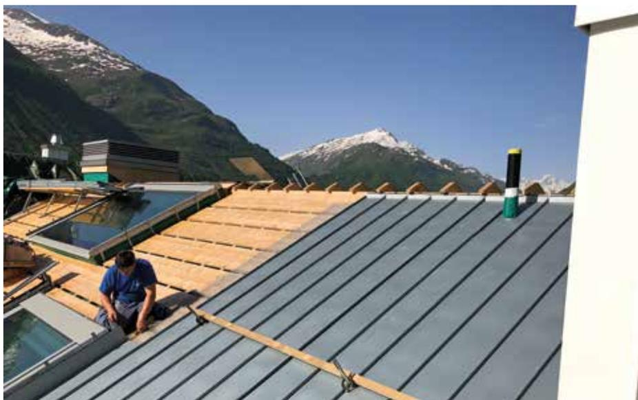
*Verlegung der Titanzink-Bahnen auf offener Holzschalung mit einer lose darauf verlegten 8 mm dicken Strukturmatte (Wirrgele).*
