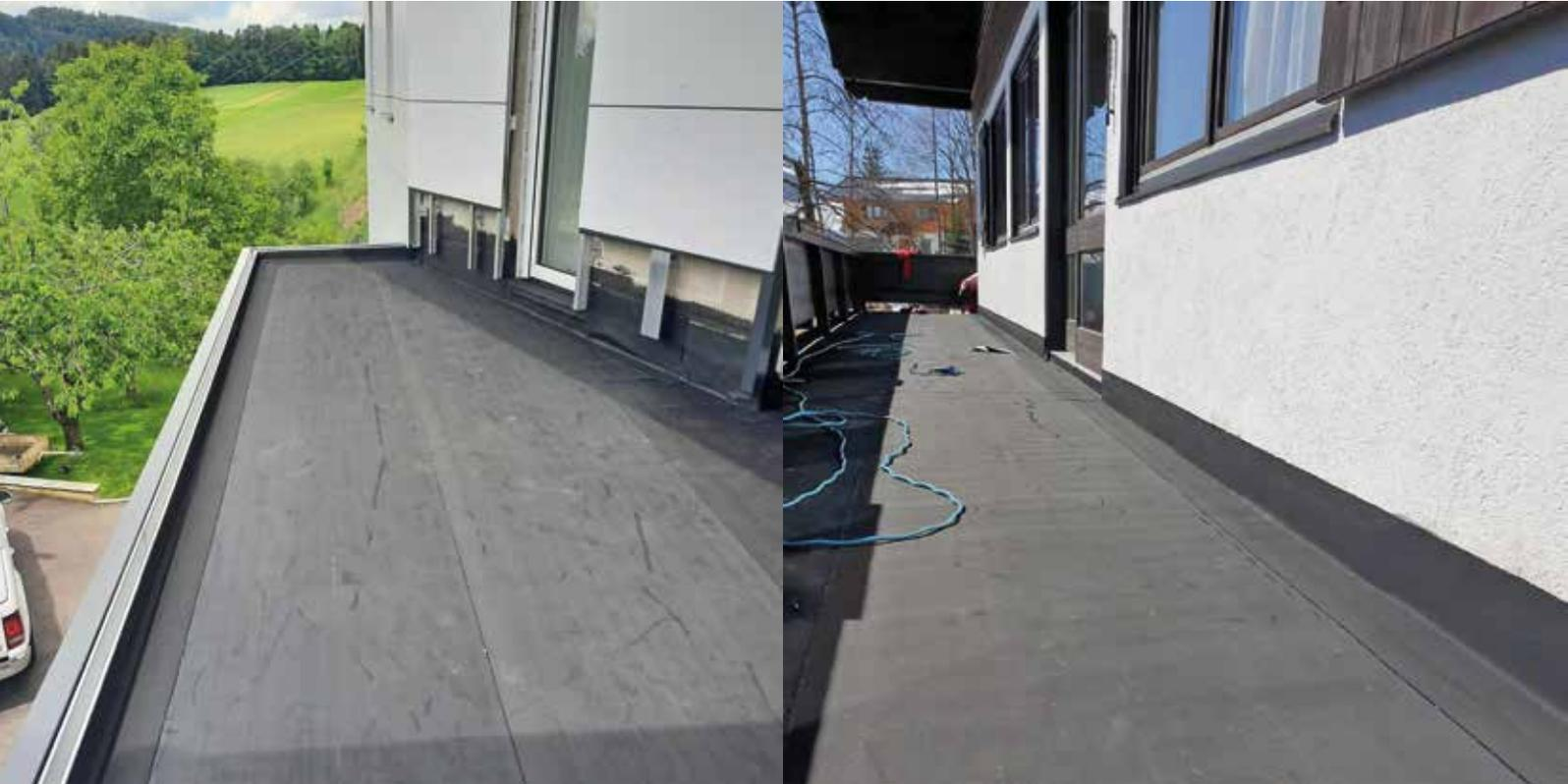
*Durch das unterseitige, polymermodifizierte Bitumen kann RESITRIX direkt auf Untergründe wie Beton, Holz, Blech, Bitumen verschweißt werden, ohne Einsatz einer offenen Flamme.*
