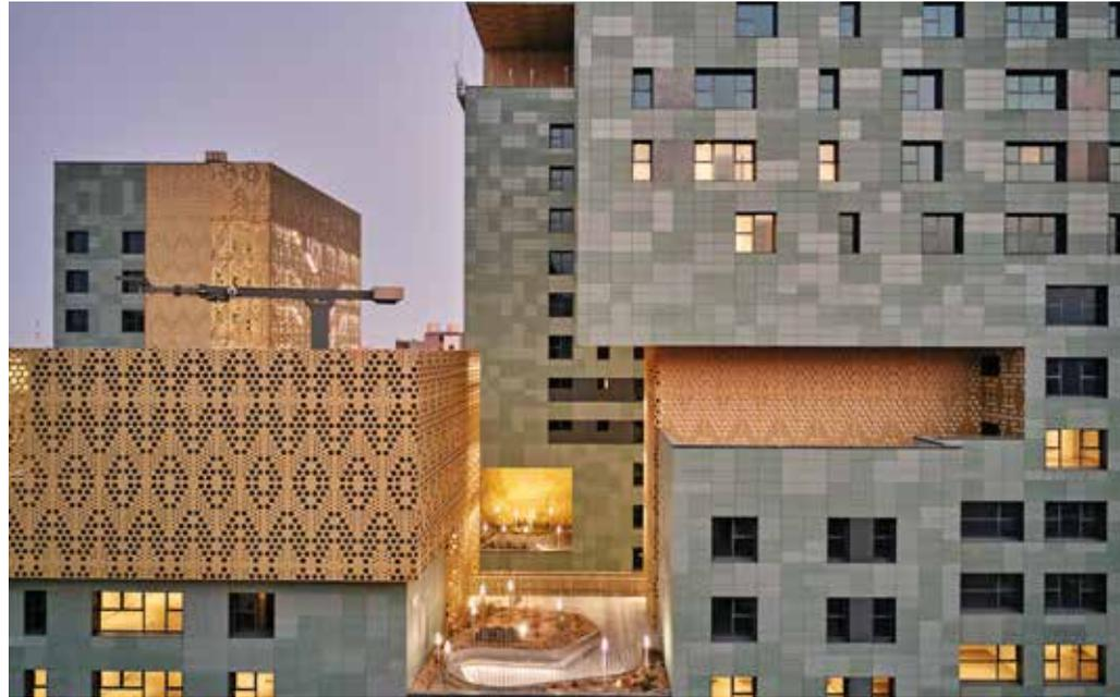
Die Konstruktion umfasst auch eine Aluminiumblende – einen „Schleier“, der als begehbare Schicht an der Fassade angebracht wurde und die Fluchttreppen und -wege unter Einhaltung ihrer technischen Anforderungen verdeckt. Das Aluminiumgewebe fungiert als doppelte Haut, die die Innenfassade erklimmt und ein Gitter schafft. | Fotos: AGi architects – © Mohammad Taqi Ashkanani (4)
