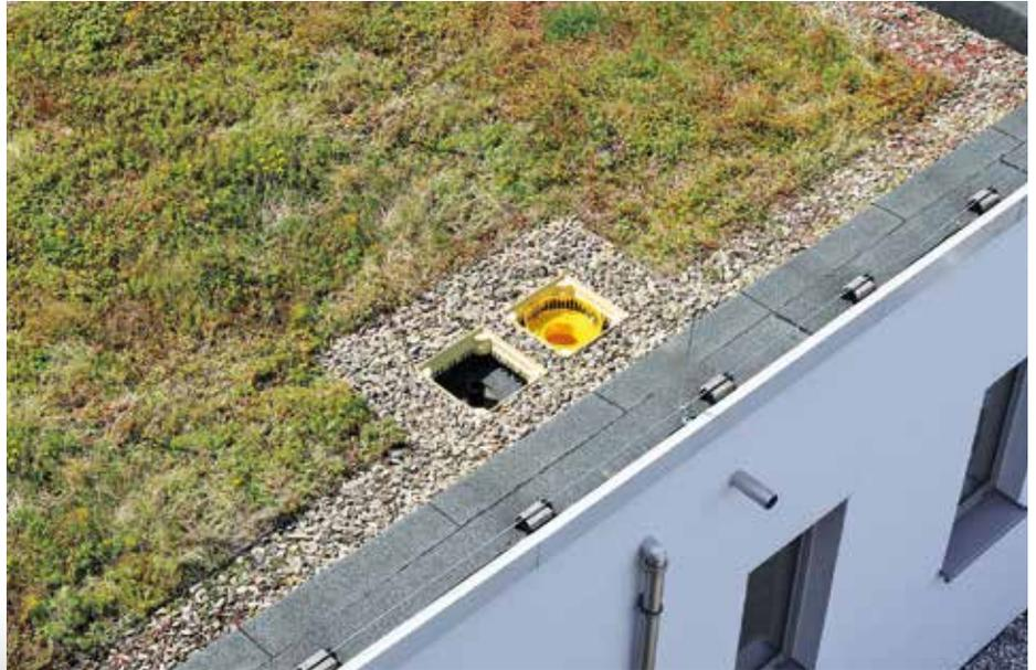
*Bild links: Schutz vor Lichteinfall und Vermoosung: Die geschlossene Abdeckplatte des SitaRetention Gründachschaichts sorgt dafür, dass die Retention planmäßig laufen kann. | Bild rechts: Haupt- und Notentwässerung Seite an Seite – jeweils verbaut in einem Gründachschaicht.*
