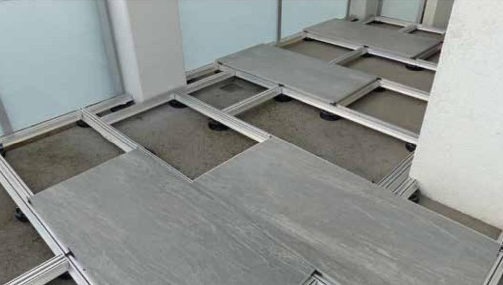
*VersiJack K besteht aus 6 Stelzlager im Höhenbereich von 14mm bis 300mm und verfügt über eine Druckfestigkeit von über 900kg.*
