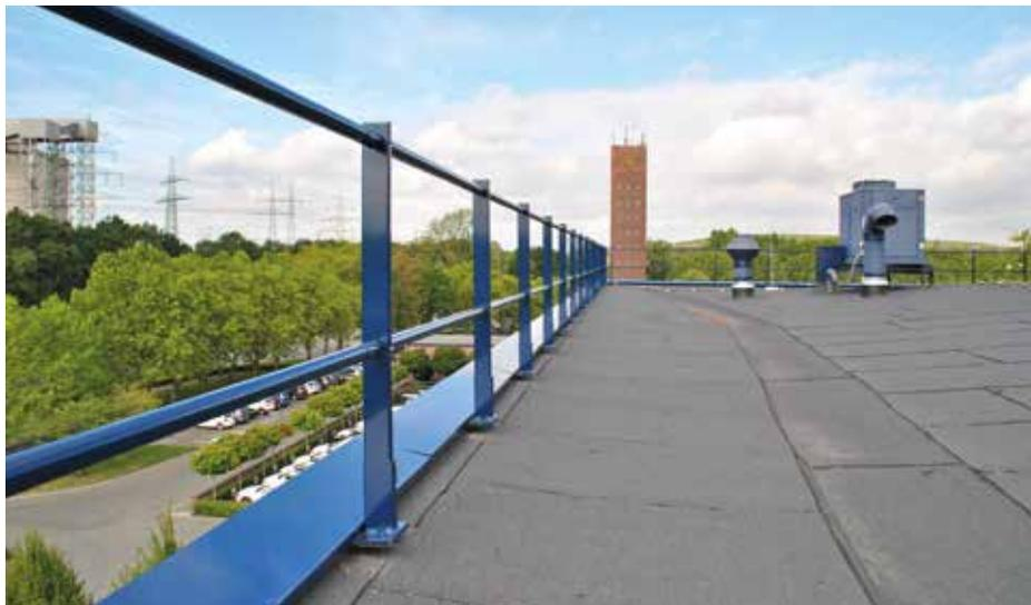
Die SKB Geländer sind für Dachneigungen von 0° bis 30° einsetzbar, sie sind höhenverstellbar im System von mindestens 10 cm und auch geeignet für geringe Absturzhöhen.
