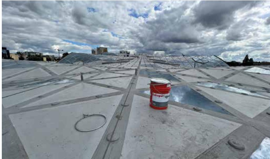
Fertig verlegte Flüssigkunststoffabdichtungen verfügen über ein Flächengewicht von ca. 3 bis 3,5 kg/m<sup>2</sup> und sollten damit keine Statik in den Grenzbereich der Tragfähigkeit führen.
