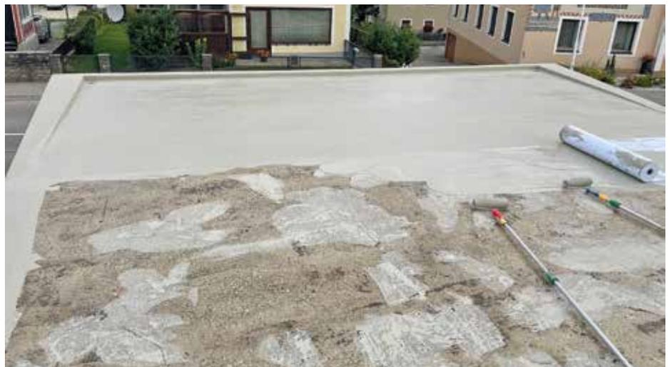
Der Bauherr entschied sich für eine Flüssigabdichtung von Triflex auf PMMA-Basis. Bevor diese appliziert werden konnte, wurden zunächst kleinere Ausbrüche auf der 80 m<sup>2</sup> großen Dachfläche mit Triflex Cryl Spachtel ausgebessert und eine Grundierung für mineralische Untergründe aufgetragen. Anschließend wurde in einem ersten Schritt Triflex ProDetail am Dachrand verarbeitet, bevor auf der Fläche Triflex ProTect aufgetragen wurde.
