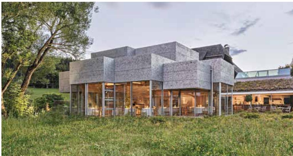
*Die Dächer sind als Folienwarmdach mit Kiesschüttung auf einer CLT Konstruktion ausgeführt. Die Entwässerung erfolgt in Kaskaden über Speier bis zu den untersten Dachflächen, diese leiten das Regenwasser über außenliegende Regenrohre in eine Brauchwasserzisterne.*
