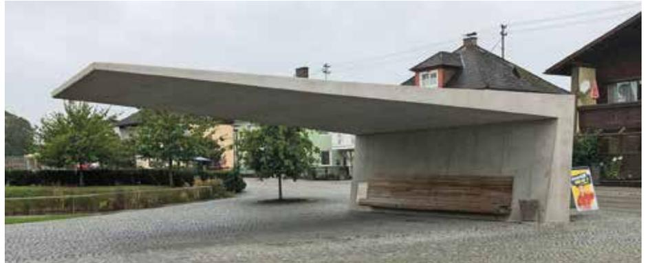
Im Zuge der Neugestaltung des Ortskerns von Handenberg wurde ein Flugdach mit 12 Metern Auskragung errichtet. Die Stahlbetonkonstruktion bietet den Bürgerinnen und Bürgern nicht nur Schatten, sondern steht als besonderes architektonisches Objekt für sich. Zum Schutz vor Witterungseinflüssen war eine Abdichtung gefragt. | Fotos: © Triflex (3)
