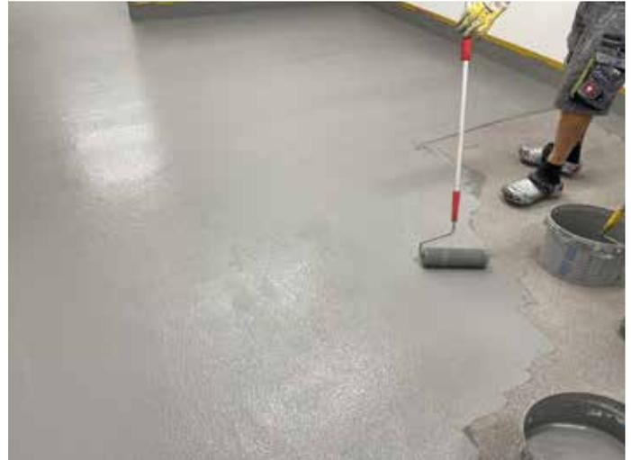
*Abschließend versiegelten die Handwerker die Fläche mit Triflex Cryl Finish 209. Für die farbige Gestaltung wurden hier Micro-Chips eingestreut.*
