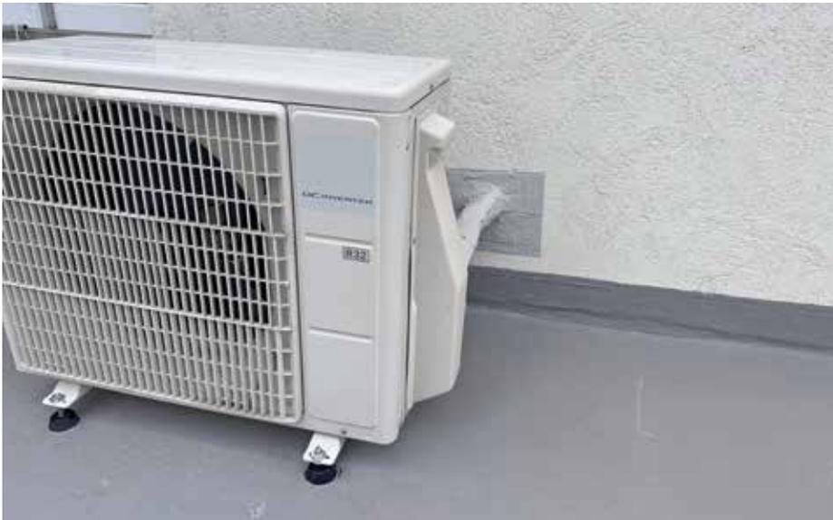
Abdichtung der Klimaleitungen mit Flüssigkunststoff.
