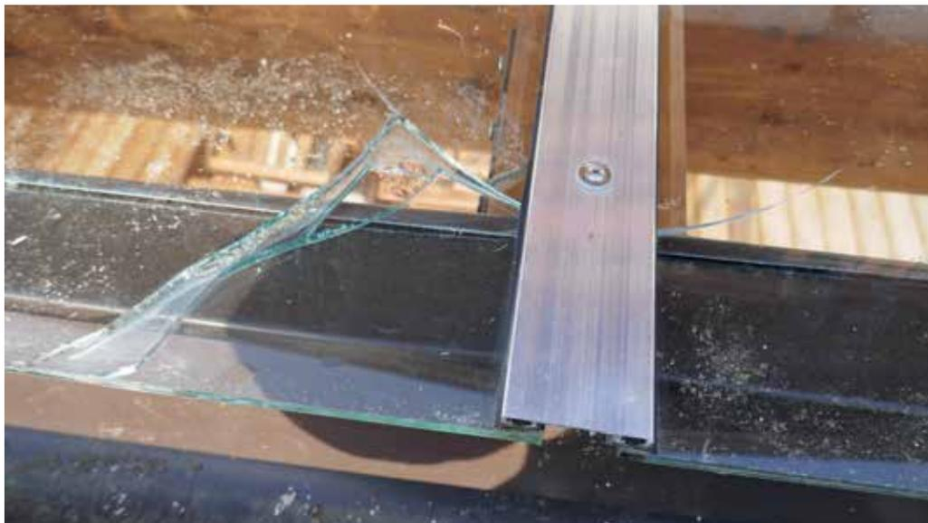
*Glasbruch durch punktuelle Belastung am Umschlag des Einlaufbleches, zusätzlich unerlaubter Glas-Metall-Kontakt.*
