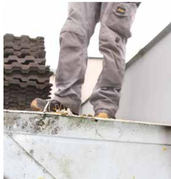
Bild links: Zeigt den Übergang von Steildach zu Blechdach. Konterlattung und zweite Schalungsebene fehlen gänzlich. Das von oben kommende eingeleitete Wasser wird unterhalb des Blechdaches angestaut. | Bild rechts: Die Blechdachtraufe ist völlig geschlossen, die Entwässerung des Unterdaches erfolgt hier hinter die Fassadendämmung.
