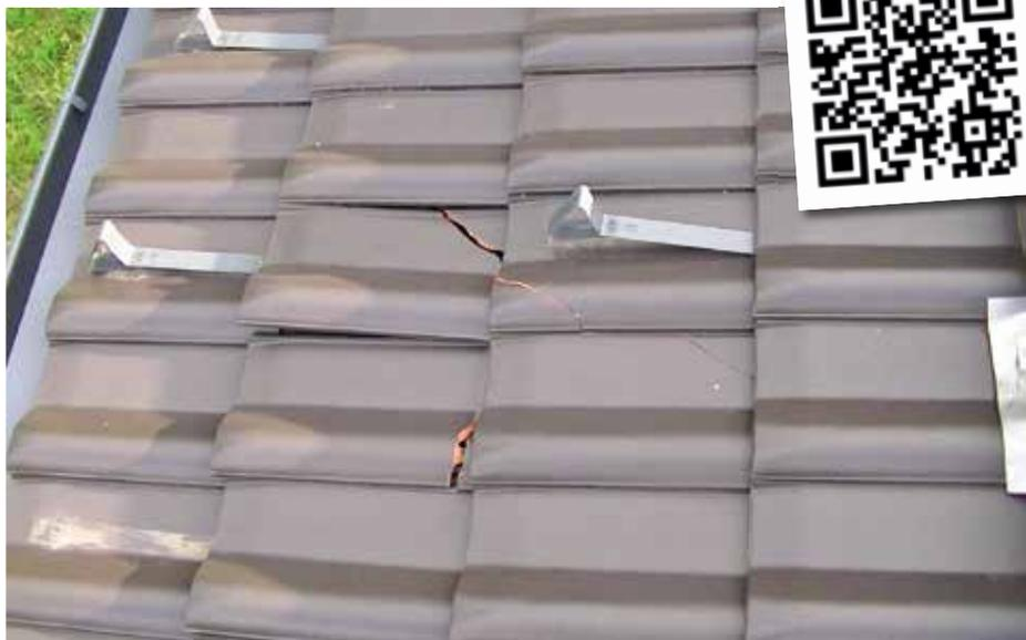
Beim heller snowstop system handelt es sich um speziell geformte Metallbügel, die entweder direkt an der Dachkonstruktion oder am Dachziegel eingehängt werden.
