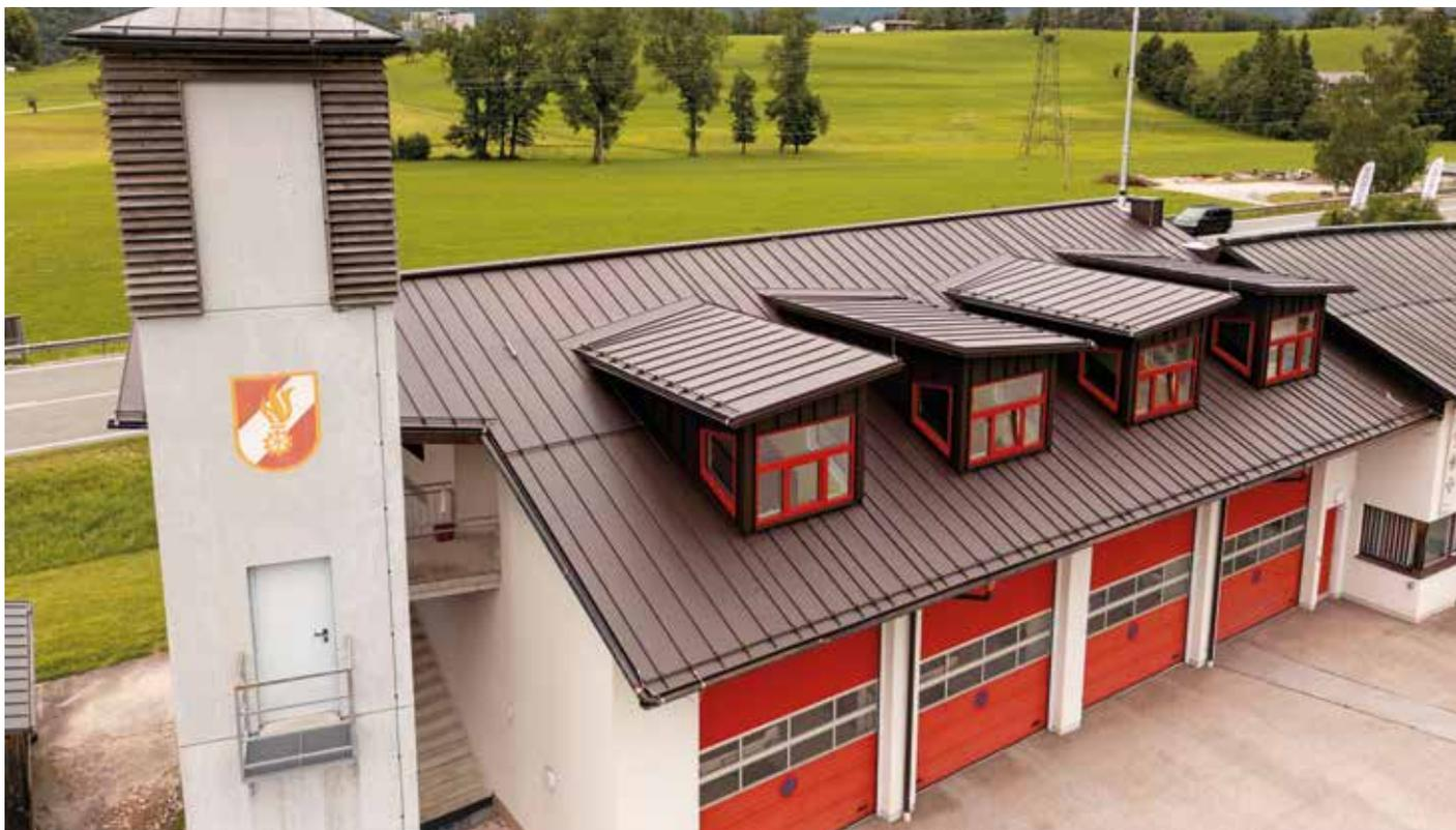
*DUOFALZ ermöglicht dem Spengler eine Doppelstehfalzdeckung auszuführen, die sowohl höchste Regensicherheit garantiert als auch gestalterische Freiheit bei der Dachgestaltung erlaubt. | Fotos: © Filli Stahl (2)*
