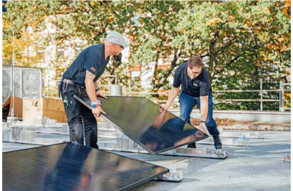
Auf den Dächern müssen bei der Planung eine Vielzahl an Funktionen bedacht werden – Entwässerung, Dämmung, Blitzschutz, PV-Anlagen, Dachbegrünung und eben auch Absturzsicherung. | Fotos: © ABS Safety GmbH (2)
