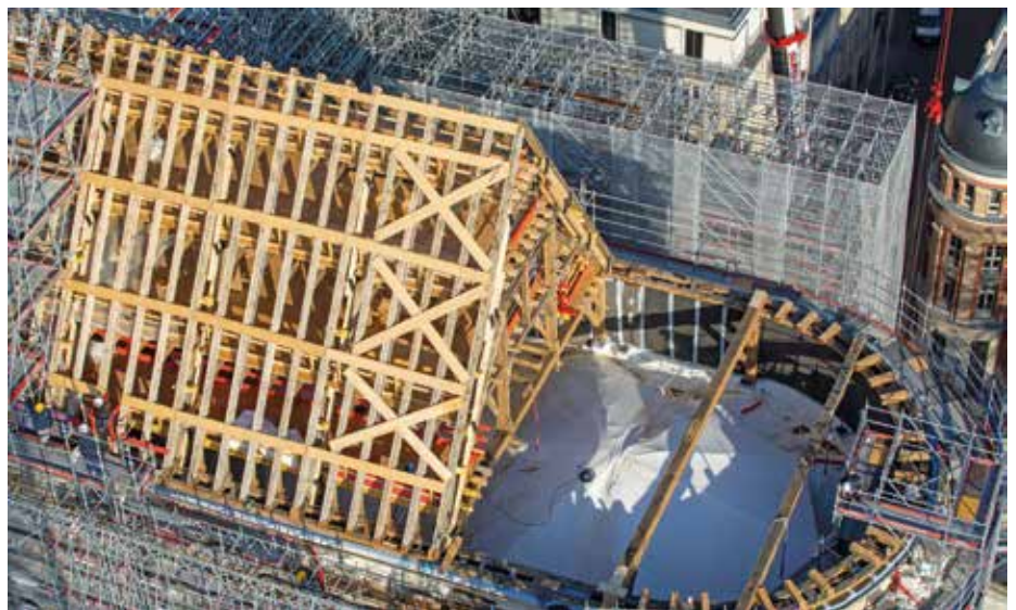
Die zerstörte Dachkonstruktion von Notre-Dame wurde aus Eichenholzsparrnen nachgebaut. Um die Sicherheit und Langlebigkeit zu gewährleisten, wurden kritische Verbindungspunkte mit Edelstahlverstärkungen versehen.
