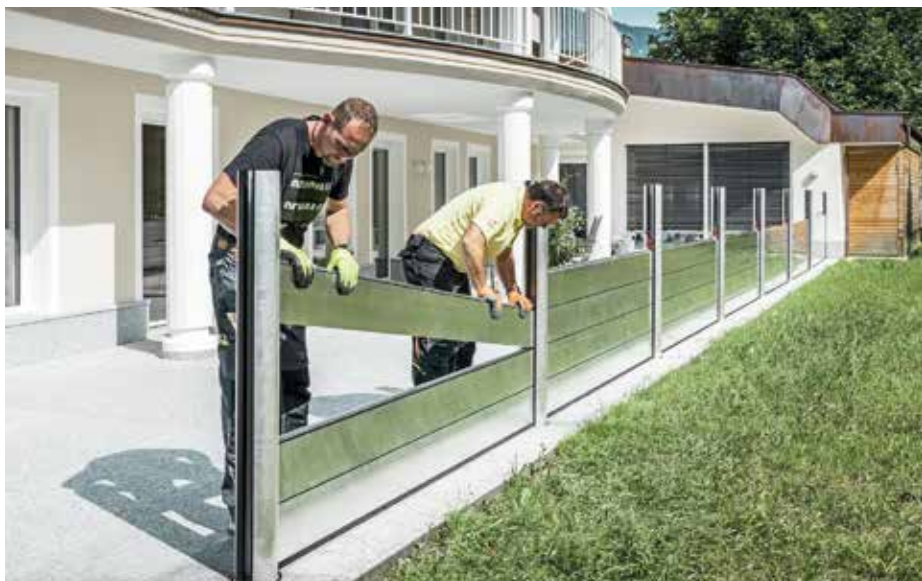
Das PREFEA Hochwasserschutzsystem bietet mit seiner robusten, modularen Bauweise effektiven Schutz für Objekte und Infrastruktur und wird kontinuierlich verbessert.
