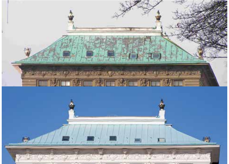
Für die Sanierung und den dauerhaften Schutz von Blechdächern bietet das System Bessemer RS Grund + Bessemer Ambos eine herausragende Witterungsbeständigkeit und effektiven Korrosionsschutz.
