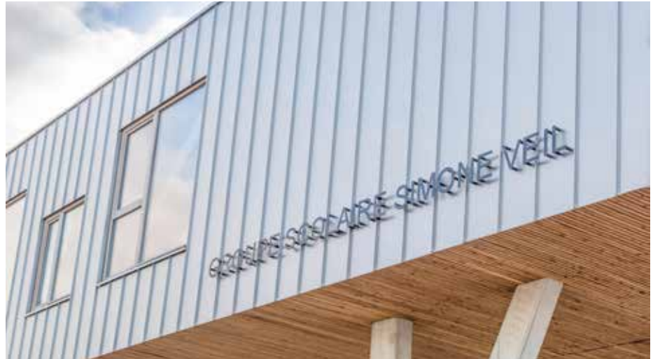
Matt mustergewalzte Oberfläche 2F, Werkstoff 1.4301 | Foto: © Aperam
