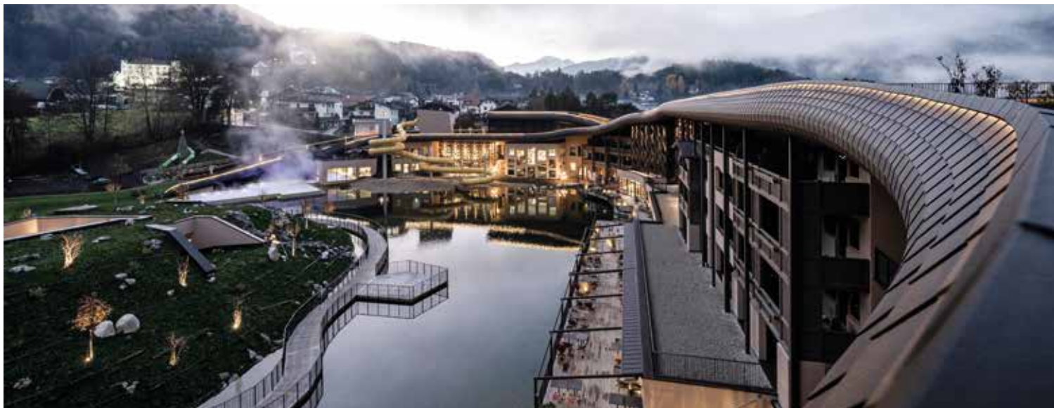
Das Tragwerk besteht im neu errichteten Teil aus Stahlbeton, während über dem bestehenden Gebäude ein System aus Stahlträgern und Holz verwendet wurde. Die Dachkonstruktion wird mit Metallschindeln verkleidet, die sich wie eine zweite Haut an die Kurven und Wellen des Daches schmiegen.
