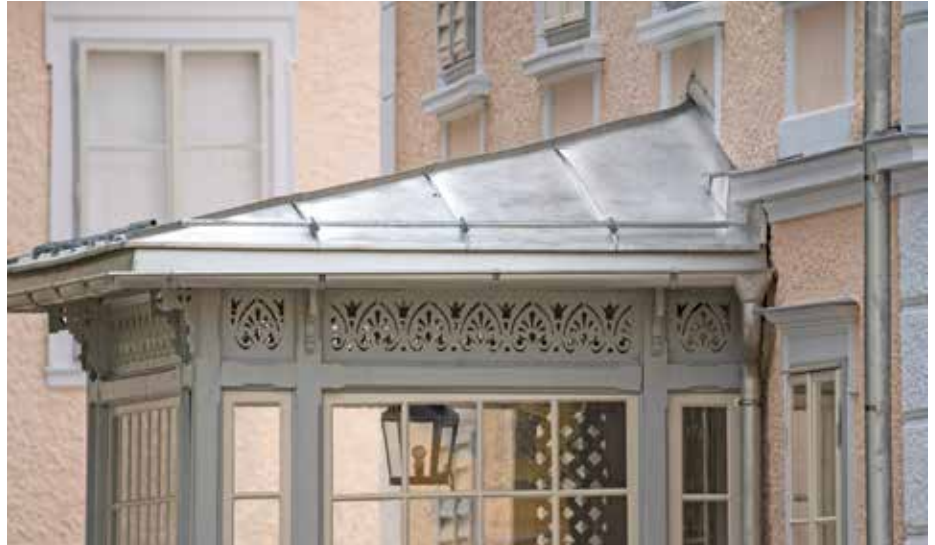
Verzinnte Oberfläche 2S, Werkstoff 1.4509 | Foto: © Aperam
