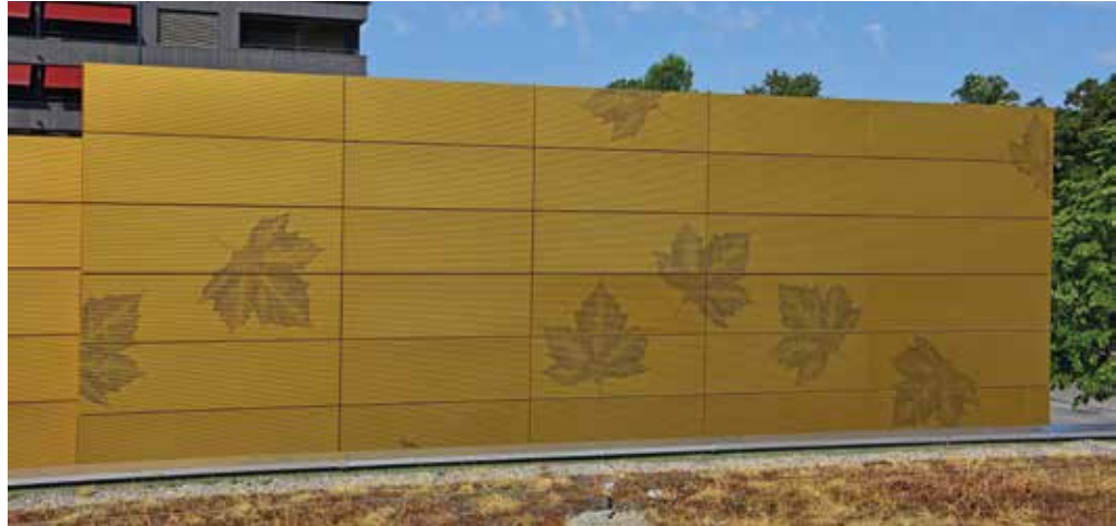
Die Metallbekleidung legt sich wie ein goldenes Band um das Obergeschoss des Pfarrzentrums. | Fotos: © Christian Zeuch, VDSS (4)
