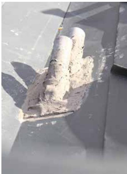
*Bild links: Die Höhe des Notablaufs beträgt 10 cm über der Abdichtung und damit um mindestens 5 cm zu hoch. Es überstaut damit den Türanschluss um 5 cm. | Bild rechts: Die „künstlerische“ Ausgestaltung des Notablaufs in der Ichse. Technisch ist diese Ausführung völlig untragbar, da auch die Übergriffe des Flüssigkunststoffs zu den angrenzenden Schichten nicht den Vorgaben der ÖN B 3691 entsprechen. Optisch ist dies ein „Totalschaden“.*
