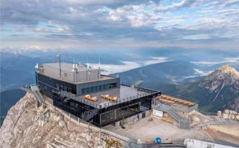
Der obere Teil der Bergstation am Dachstein besteht aus einer speziellen Trapezblechfassade, die extremen Wetterbedingungen, von eisigen Stürmen bis hin zu starker UV-Strahlung, standhält. | Fotos: © Harald Steiner (2)
