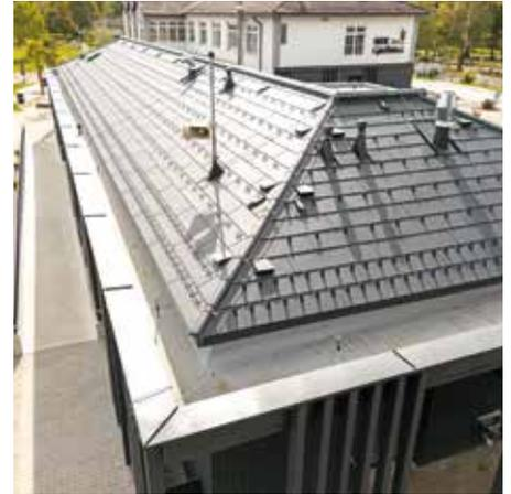
FIGO Amade Dachplatten überzeugen aufgrund ihrer Kombination aus Qualität, Langlebigkeit und zeitgemäßem Design. Hergestellt in Österreich von Filli Stahl in Scheiffling, besteht das Material aus greentec steel der voestalpine. | Fotos: © Stefan Kobald (2)
