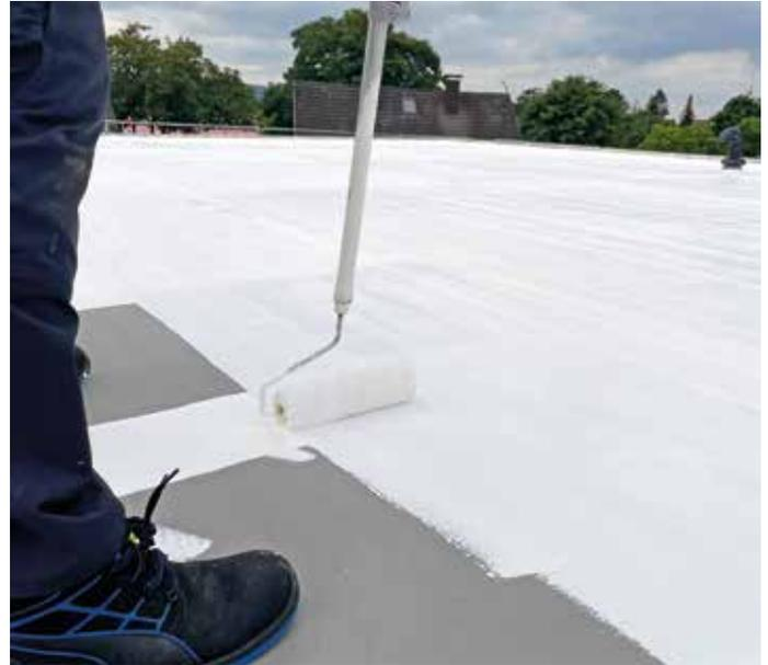
*Der helle Farbton von Triflex ProSolar Finish+ erhöht den Reflexionsgrad und senkt gleichzeitig die Oberflächentemperatur. Das Produkt wird mit der Walze gleichmäßig aufgetragen und im Kreuzgang verschlichtet. | Fotos: © Triflex (3)*
