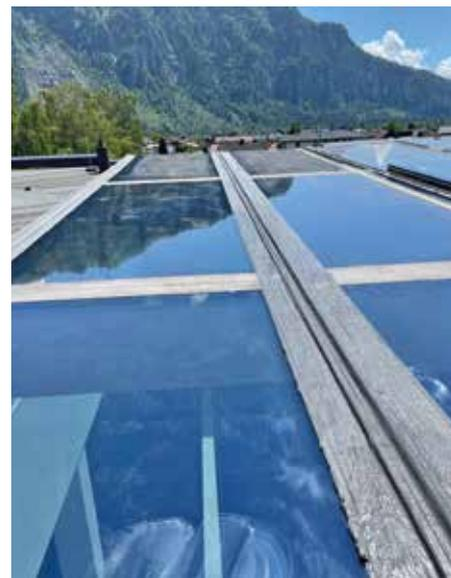
*Der Untergrund wurde zunächst gereinigt, Glasflächen mit Kreppband abgeklebt. Die Grundierung erfolgte mit dem Triflex Glasprimer-Set. Anschließend wurde die Abdichtung mit Triflex ProDetail appliziert. Das Ergebnis ist eine naht- und fugenlose Oberfläche, die mechanisch hoch belastbar ist und somit eine Versiegelung der Fenster langfristig gewährleisten kann.*
