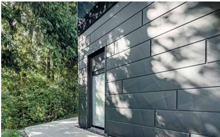
*Alle PREFA Sidings in den Standardbaubreiten mit der dazu abgestimmten Standardmaterialdicke sind statisch geprüft und es liegen umfassende Belastungstabellen vor, die die Stabilität und Sicherheit der Produkte bestätigen.*
