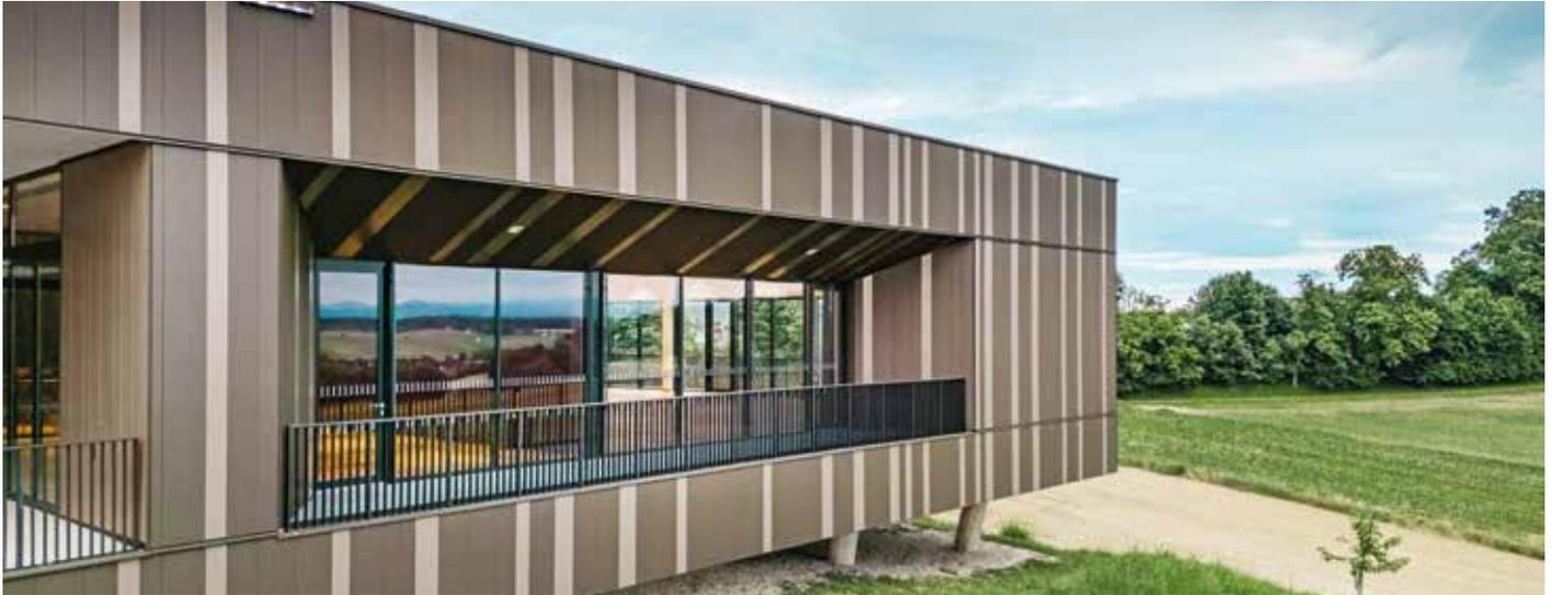
*Die PREFA Sidings sind in den bewährten Standardbaubreiten von 138 bis 400 mm erhältlich und überzeugen mit der üblichen Kombination aus Baubreite und der dazu abgestimmten Materialstärke. | Fotos: © PREFA / Croce & Wir (3)*
