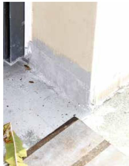
*Bild links: Unter der Beschattungsschiene ist das Einlagevlies der Flüssigabdichtung frei sichtbar. Kein Anschluss der Abdichtung in der Leibung am Türstock. Die Hochzughöhe ist völlig unzureichend. | Bild rechts: Auch hier wurde die Flüssigabdichtung nur auf das WDVS in der Leibung aufgebracht.*
