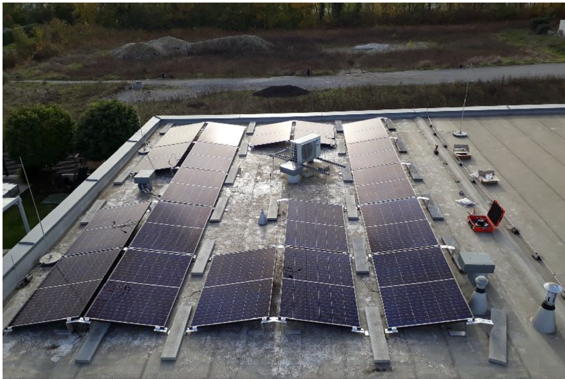
Eine fertiggestellte PV-Anlage mit Haltebügelmontage und Auflastsystem, die Haltebügel sind auch hier direkt an den PV-Modulen verschraubt.
