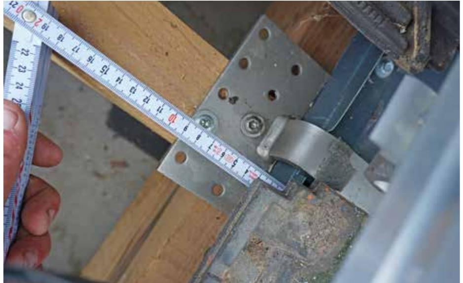
*Die verwendeten Blechersatzziegel wurden nicht über die Oberkante der Dachlatte geführt, was zu einer Reduzierung der Höhenüberdeckung führte. Dadurch entstanden Wassereintritte unter die Dachhaut. | Fotos: © Kmentt (5)*
