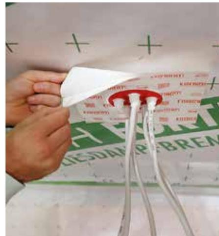
Die EISEDICHT® M-Tec6 eignet sich hervorragend für die Abdichtung von mehreren Kabeln oder Rohren mit Durchmessern zwischen 16 und 25 mm. Die Installation der Manschette ist einfach und effizient. Der selbstklebende Klebekragen ermöglicht eine schnelle Befestigung ohne zusätzliches Werkzeug.
