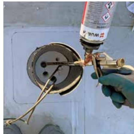
Verschließen der Löcher mit PU-Schaum.
