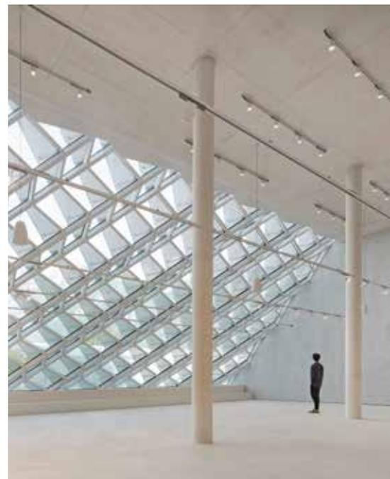
*Der Neubau ist als Betonskelettbau konzipiert, welcher auf den nach Osten beziehungsweise Westen orientierten, geneigten Fassadenflächen fast vollständig verglast ist. | Foto: © Brigida González*
