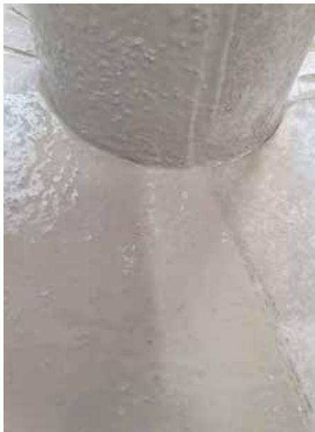
*Sichere Abdichtung – Das Universal Detailvlies von FRANKEN SYSTEMS sorgt für eine präzise Abdeckung kritischer Punkte und verhindert zuverlässig Wassereintritt.*
