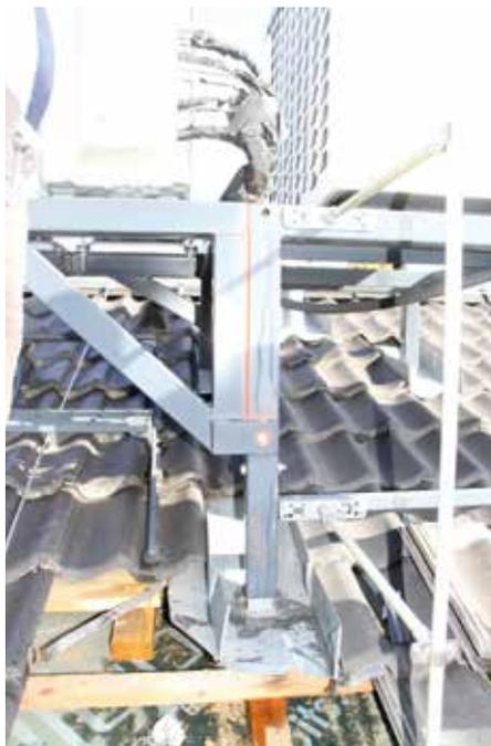
*Die Formrohrkonstruktion mit dem offenen Verzinkungsloch.*
