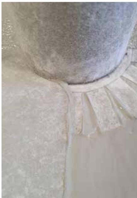
*Zeitsparende Verarbeitung – Vorgefertigte Zuschnitte reduzieren den Arbeitsaufwand auf der Baustelle und minimieren Materialverluste.*
