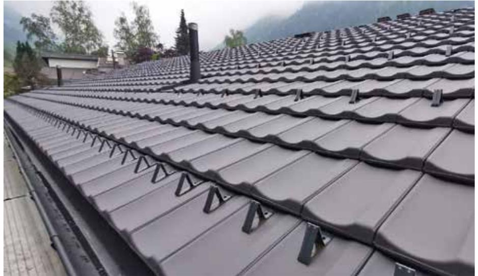
*Kaum auf Dachflächen sichtbar, weil klein und in ihrer Farbe angepasst, aber auf die gesamte Dachfläche verteilt verlegt, machen das heller snowstop system zu einem zuverlässigen Schneehaltesystem mit großer Wirkung. | Fotos: © heller metall (2)*
