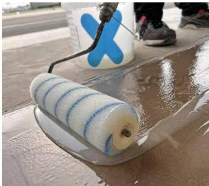
*Die Grundierung kann manuell im Rollverfahren oder aber mit der Sprüh-Applikationsmaschine Triflex SAM aufgetragen werden. Die 2-komponentige Grundierung auf PMMA-Basis haftet sicher und bildet damit die Grundlage für langlebige Abdichtungslösungen von Triflex. | Fotos: © Triflex (2)*
