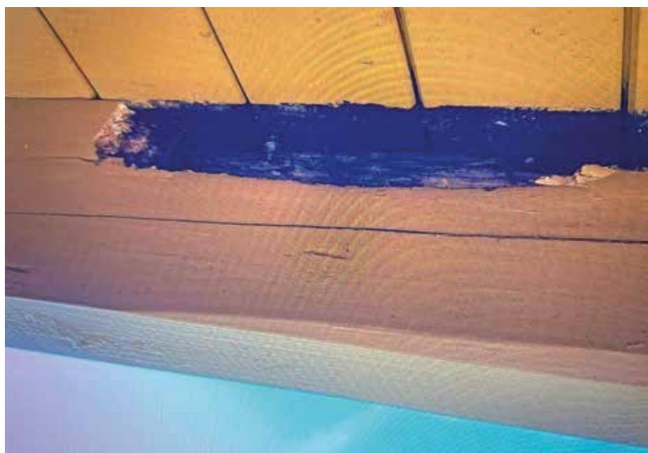
fehlt es an einer Höhenüberdeckung, welche speziell bei geringen Dachneigungen zu Wassereintritten unter die Dachdeckung führen können. So mussten aktuell bei einer größeren PV-Anlage durch mangelhafte Blechersatzziegel, aufgrund fehlender Höhenüberdeckung, über 400 Stück davon getauscht werden. Zusätzlich zu der De- und Wiedermontage der gesamten Module, der Schienenkonstruktion und der Halterungen. Dass hier erhebliche Kosten auf den Verursacher zukommen, ist überflüssig zu erwähnen.
