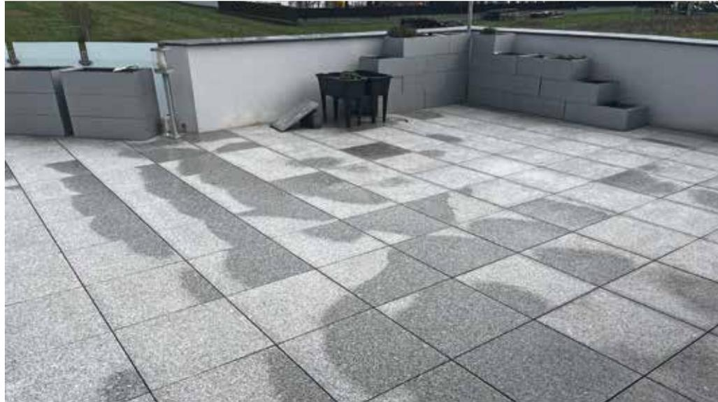
*Im Sinne der „Normen“ mangelhaft, jedoch voll praxistauglich. Vollflächig eben verlegter Granit 60x60 auf Schienen-System mit rundum freier Fuge trocknet unmittelbar nach Ende eines Regens rasch ab. Alleine die Bauimperfection bewirkt eine Neigung und vermeidet Stauwasser an den einzelnen Platten. Das Trocknen der Benetzung erfolgt durch Sonne und Wind, nicht durch das Gefälle am Belag. Bei geschlossener Fuge wäre eine große Pfütze unausweichlich.*
