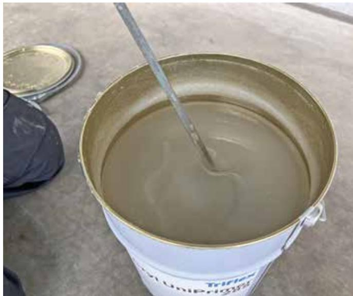
*Triflex Cryl UniPrimer 285 ist schnell reaktiv und lösemittelfrei sowie bei Temperaturen von 0 °C bis +35 °C verarbeitbar. Für die Verarbeitung wird zunächst das Basisarzne gründlich aufgerührt.*
